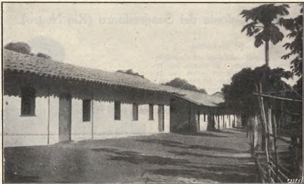
Sangradouro (Rio Negro). — Parte nuova della residenza in muratura e tegole.
